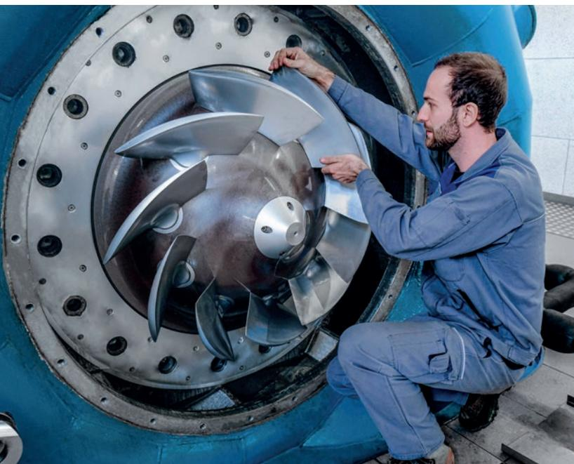
Regelmäßige Wartungen sichern Verfügbarkeit, Effizienz und Betriebssicherheit – und damit die Ertragsicherheit einer Wasserkraftanlage.
