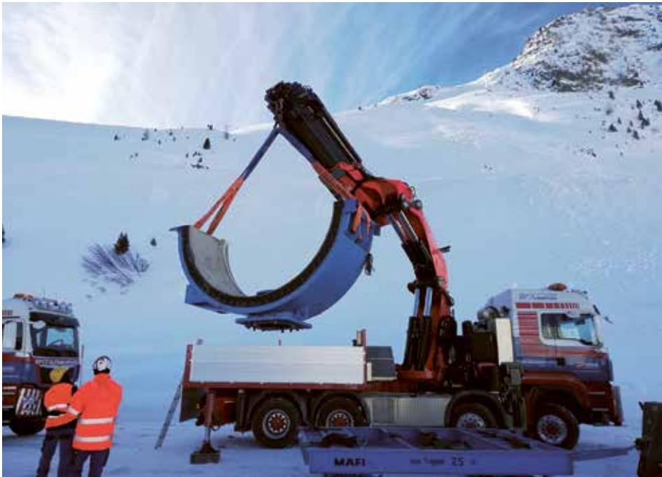
Abb. 4: Umladen einer Gehäusehälfte mit einem Mobilkran vor dem Stollenportal
