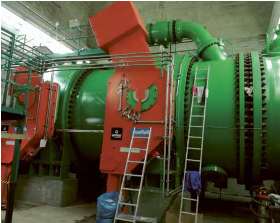
Abb. 8: Absperrklappen kurz vor Abschluss der Instandsetzungsarbeiten
