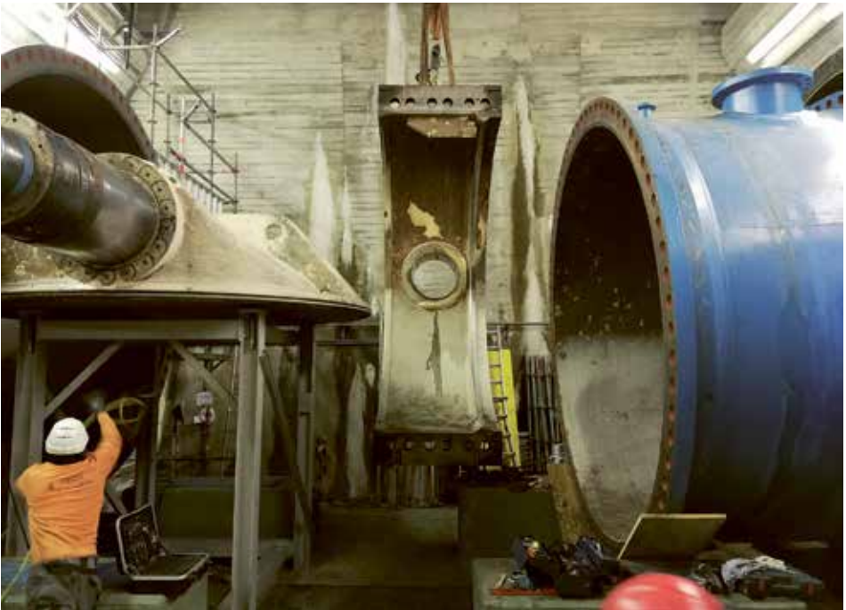
Abb. 2: Demontage der oberwasserseitigen Absperrklappe
