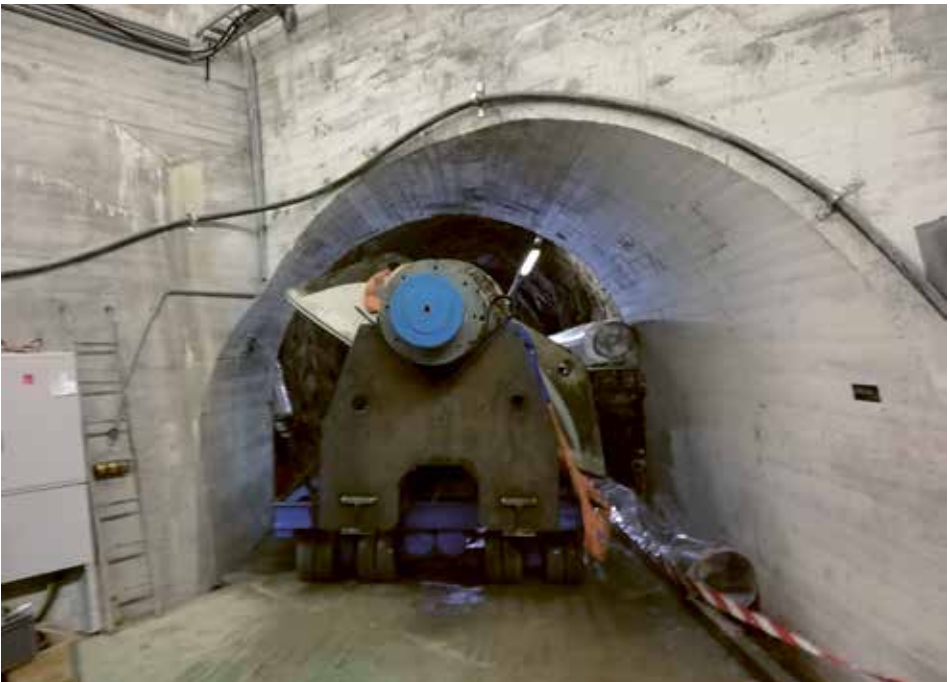
Abb. 3: Klappenteller mit Transportvorrichtung auf einem gelenkten Schwerlast-Anhänger beim Rangieren im Zufahrtsstollen
